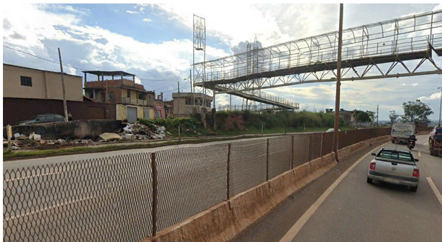
Figura 4. Dispositivos de segregação de pistas utilizados nas proximidades das passarelas instaladas nos Trechos 1 e 2 do Anel Rodoviário Celso Mello Azevedo. Fonte: Google Earth (2020).
