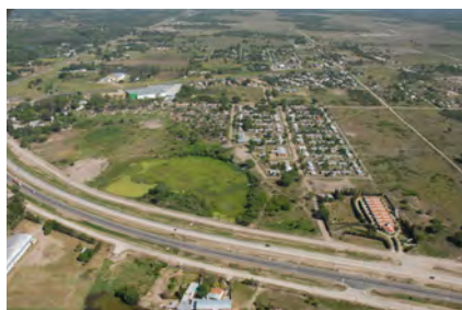
Figuras 24-25. Autovía Nicolás Avellaneda (eje de tránsito internacional y única vía de conexión de conjuntos habitacionales recientes). Fuente: la primera http://chacodiapordia.com/noticia/55605 (diciembre de 2014), la segunda Territorio Urbano 2009.
