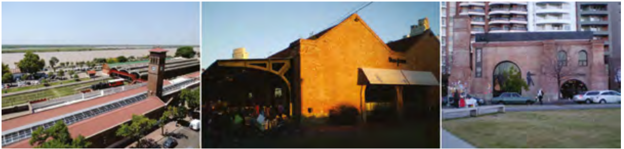
Figura 12. Complejo de la Estación Rosario Central, Galpón N° 10 y Casa del Tango. Fuente: Fotografías de la autora.
