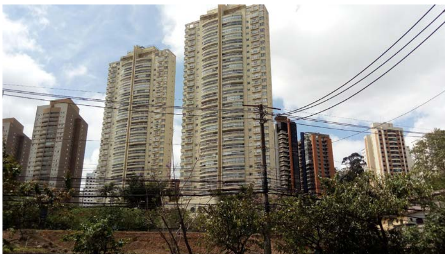
Figura 4. Torres de condomínios residenciais na parte leste da Vila Andrade. À frente, um terreno vazio, onde um novo empreendimento será futuramente construído. Fonte: Gabriella D. Dantas De Biaggi, 2018.
