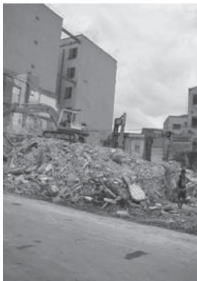
Foto 2: Demolição na Luz (Hélène Rivière D’Arc, 3/11/2007)
