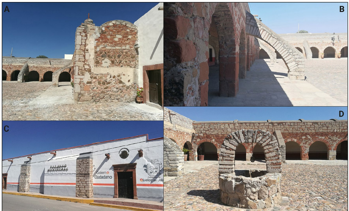
Figura 4. Estado actual del presidio de Ojuelos. A) Vista cegada del corredor del presidio; B) Vista de los contrafuertes interiores que aligeran la carga de los soportales; C) Fachada principal del presidio; D) Vista del pozo y de la plaza de armas empedrada. Fotografía de Alberto Puig Carrasco.
